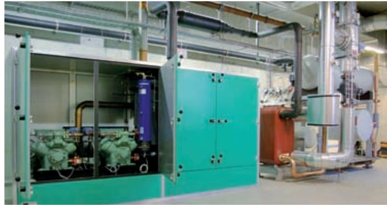
Der Einsatz von Wärmepumpenanlagen mit Mehrfachnutzungen bietet besondere Vorteile; die Forschungs- und Entwicklungsarbeiten konzentrieren sich auf weitere Wirkungsgradverbesserungen und optimierte Systemeinbindung. Eine 450-kW-Wärmepumpe bezieht die elektrische Antriebsenergie von einem Gasmotor-Blockheizkraftwerk und bildet ein Element der Energiezentrale für einen grösseren Gebäudekomplex.
