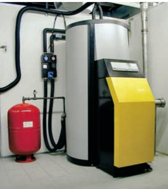
Des systèmes compacts pour la production d'eau chaude sanitaire et le chauffage sont testés à la Haute école spécialisée de Rapperswil. Les résultats prometteurs indiquent que, grâce à une conception compacte et à un système optimisé, une amélioration nette de l'apport solaire et une réduction simultanée des prix de revient sont possibles.
