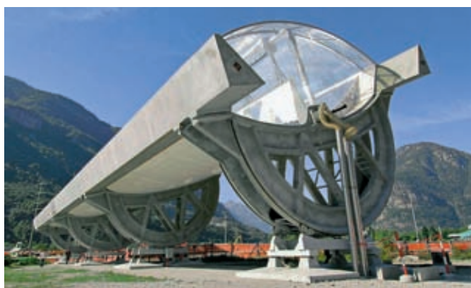
Il terzo prototipo messo in funzione presso la ditta AirLight Energy di Biasca. Il collettore a concentrazione presenta una configurazione lineare e sfrutta uno specchio flessibile pneumatico di nuovissima concezione, le cui membrane sono fissate su un semplice quadro prefabbricato di calcestruzzo precompresso.
